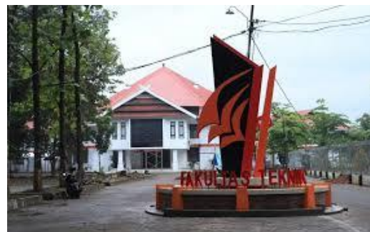
Gambar 4. Gedung Dekanat Fakultas Teknik
