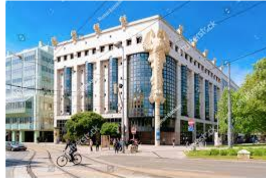
Gambar 6. Jalan Penghubung Jalan Antara Bangunan Kampus TU Wien.
