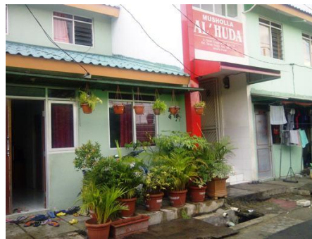
Gambar 2. Kondisi kampung deret yang rapi dan kualitas bangunan baik
