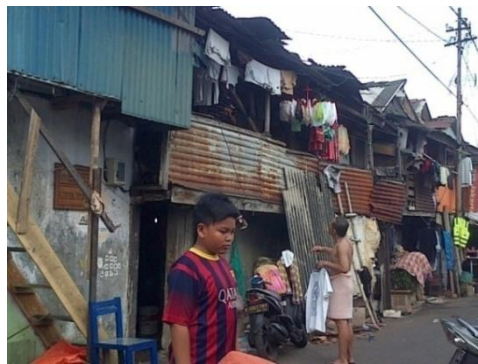
Gambar 7. Rumah kumuh RT 13 bagian depan
