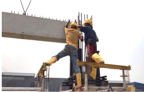
Gambar 9. Proses join erection komponen kolom dan balok (sumber : data survey 2018)
